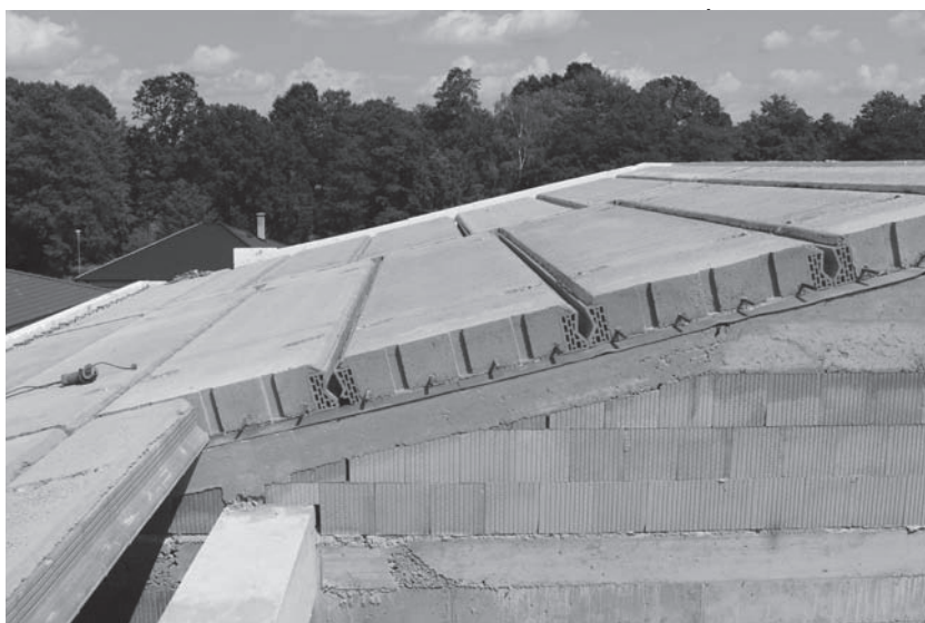
Obr. 4: Těžká šikmá střecha z keramobetonových panelů
