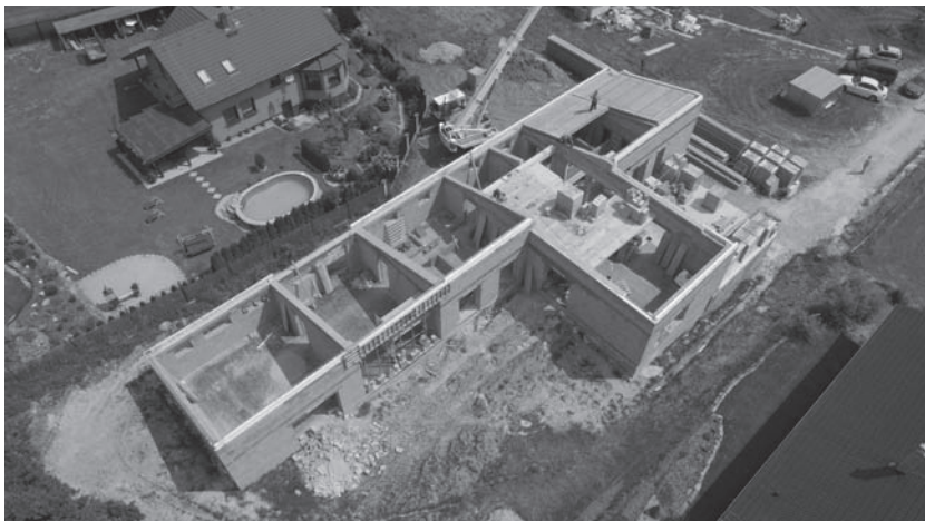
Obr.5: Nosnou konstrukcí těžké šikmé střechy je vhodné ukládat na nosné stěny v pravidelném rastru.
