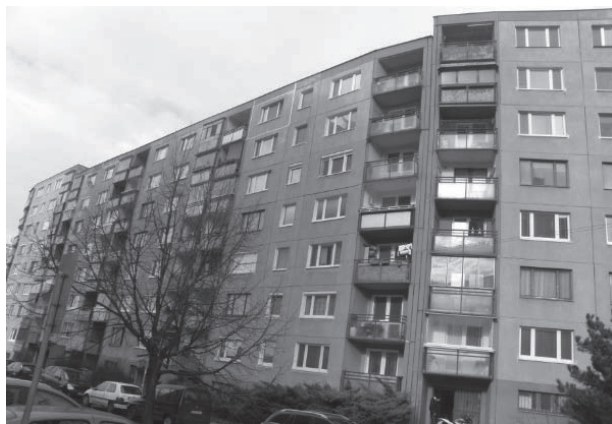
Obr. 1 Pohľad na priečelie bytového domu v pôvodnom stave
