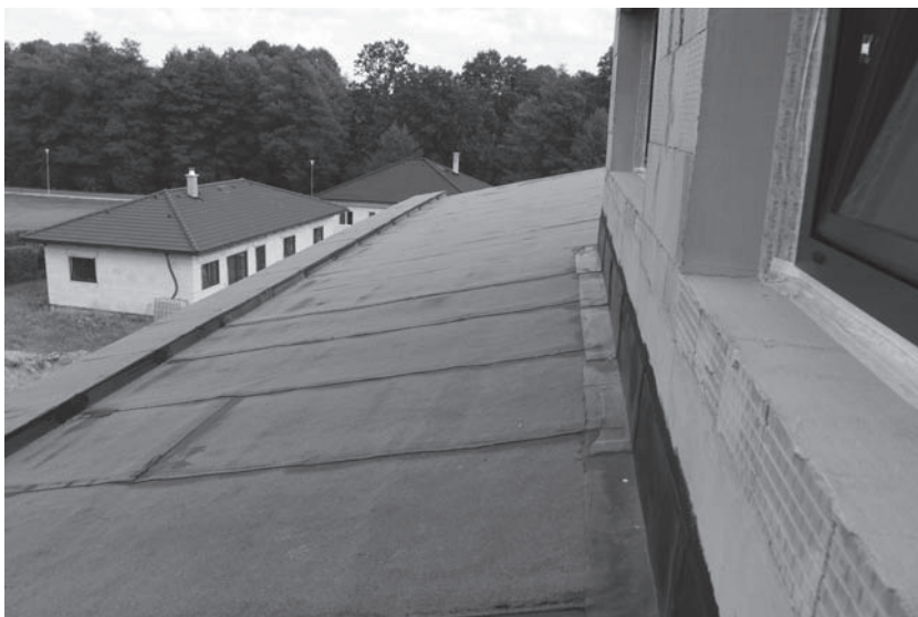
Obr. 6: Ukázka provedení parozábrany ve formě asfaltového pásu, která má ve fázi hrubé stavby funkci dočasné hydroizolace a ve fázi dokončené stavby funkci doplňkové vduchotěsnicí vrstvy.
