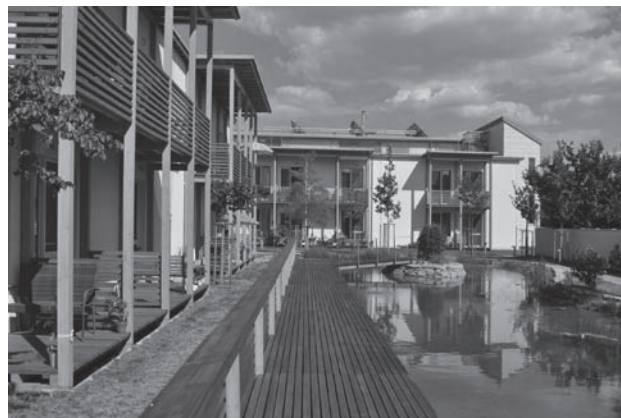
Obr. 2 PBDS v Modřicích
