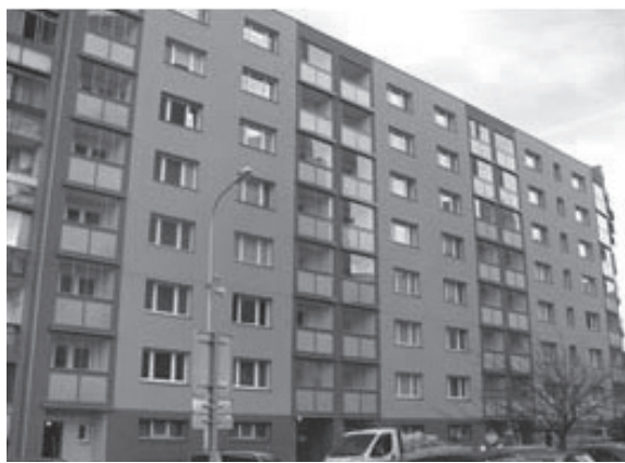
Obr. 2 Pohľad na priečelie po obnove
