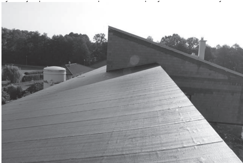
Obr. 8: Ukázka položené střešní krytiny ve formě asfaltových pásů.
