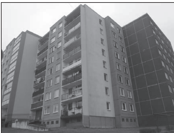
Obr. 1 Pohled na uliční fasádu budovy
