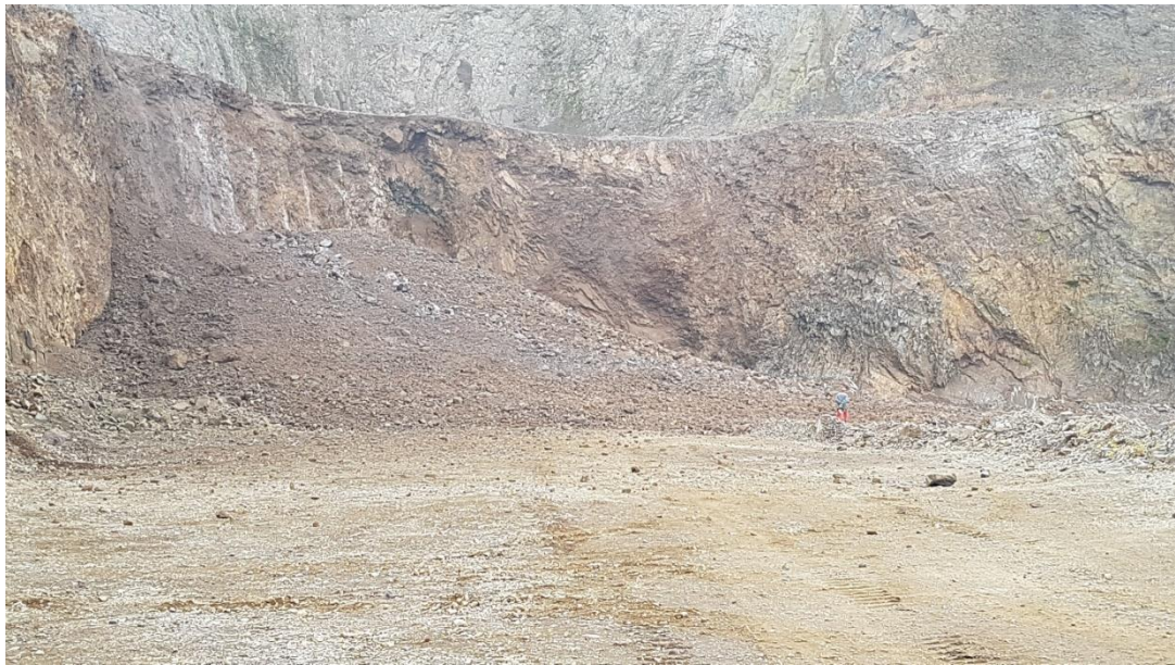
Obr. Kontrola rozvalu po odstrele
