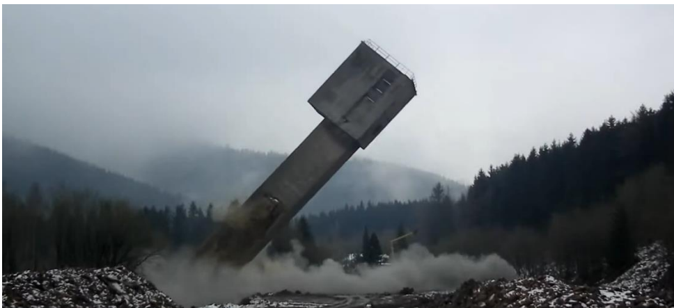
Obr. Objekt po odstrelе
