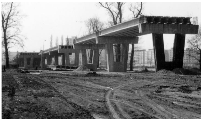
Obr. 2: Výstavba estakád dočasnej trasy rýchlodráhy v Petržalke. Fotografia Ján Horník
